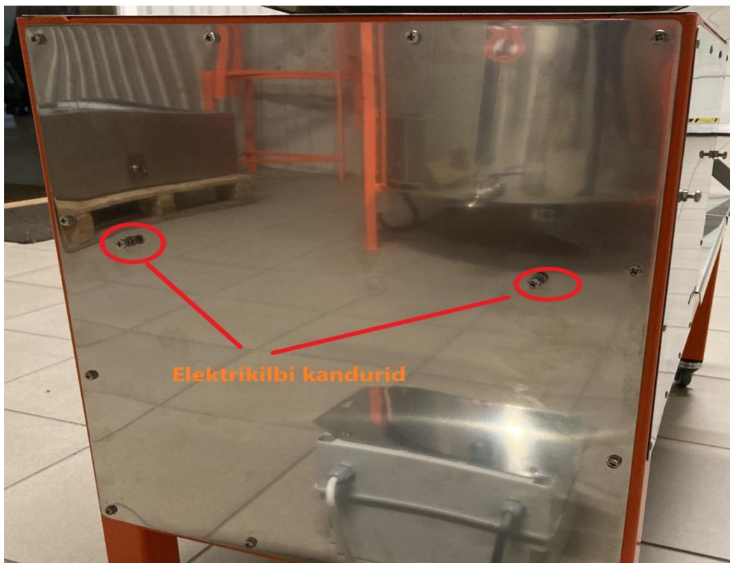
Tagumise otsa kandurid elektrikilbile
